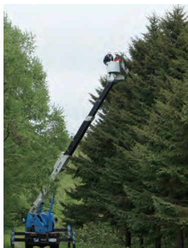
写真6-3 | 高さ10m以上の高所作業車による作業(林木育種センター 業務資料より)
